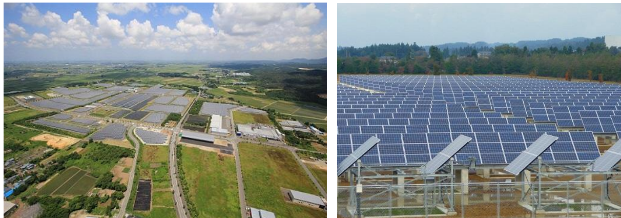
図 2-1 新潟東部太陽光発電所
